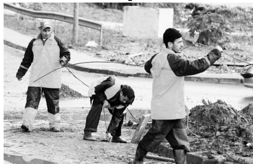
leur efficacité. Les réseaux d'assainissement peuvent être affectés par des dépôts de graisses, de déchets ou encore de tartre. Ces éléments entravent la circulation des eaux usées provoquant des mauvaises odeurs persistantes, des écoulements lents dans les éviers, bouches ou autres. Des risques de débordements notamment dans les gosses sceptiques ou des réseaux d'assainissement obstrués. Le curage des canalisations peut être pré-
